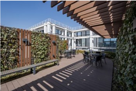
UUR京橋イーストビル
