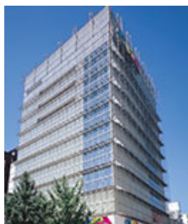
A15 心斎橋OPA本館
