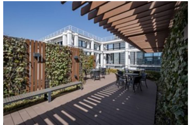
UUR京橋イーストビル
