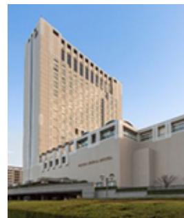
C15 リーガロイヤル ホテル 小倉・あるあるCity (あ るあるCity)
