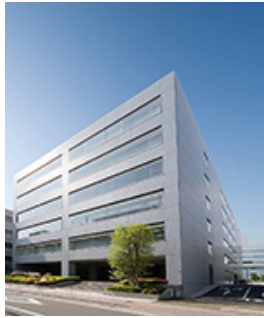
B8 UUR東陽町ビル
