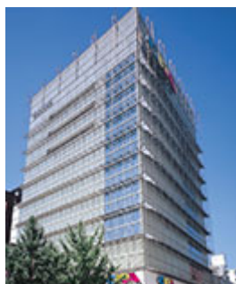
A15 心斎橋OPA本館
