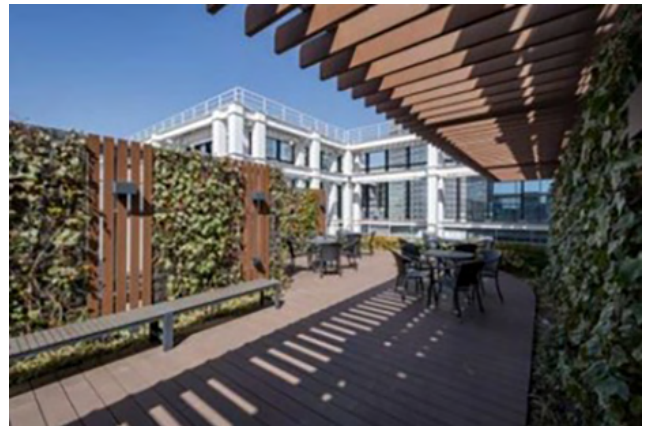
UUR京橋イーストビル
