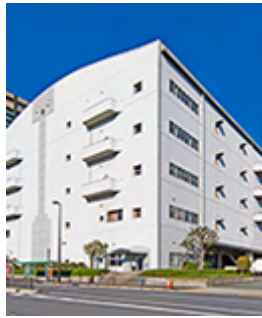
E6 第1MT有明センタービル
